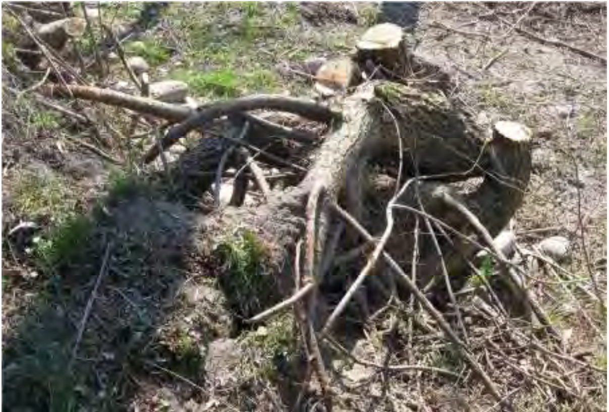
Braone: bonifica forestale della vegetazione ripariale a rischio di scalzamento (2018)
